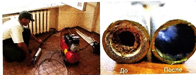
Рисунок 15. Промывка батареи
