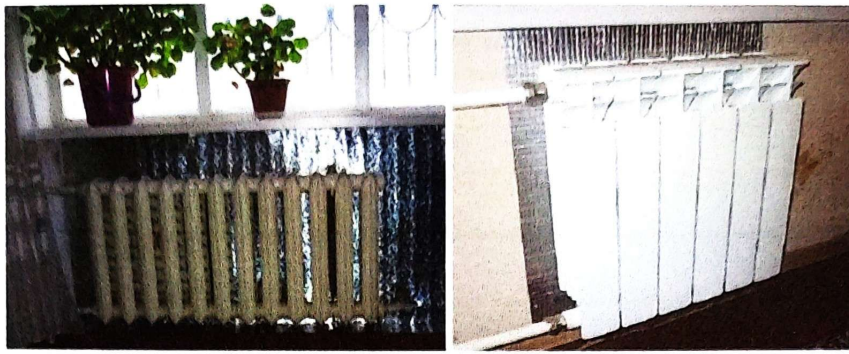
Рисунок 9. Отражающая теплоизоляция, установленная за отопительными приборами
