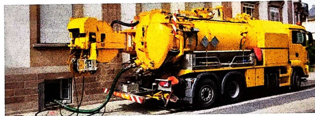
Рисунок 13. Химпромывка системы отопления здания
